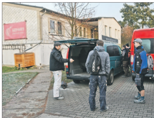
Arbeiten statt Absitzen: Morgendlicher Aufbruch zur Baustelle und in die Werkstatt auf dem Hof des Störmthaler Seehauses.
